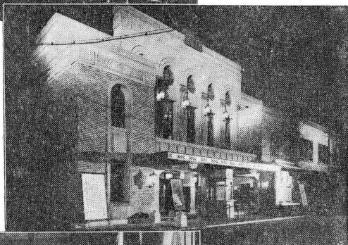
文樂座外観全景
